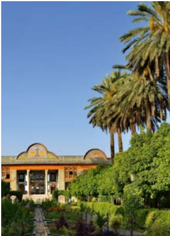
La maison Narendjestan-Qavam.
