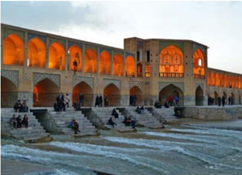
Le pont Khwaju, le plus beau pont ancien de la ville (XVIIe siècle).
